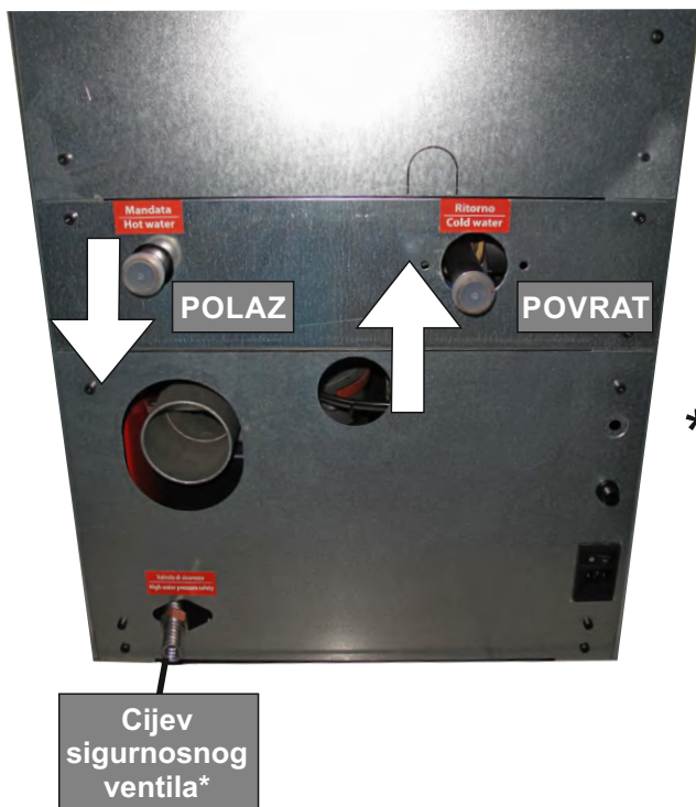
Slika 5. Polaz, povrat i cijev sigurnosnoga ventila
